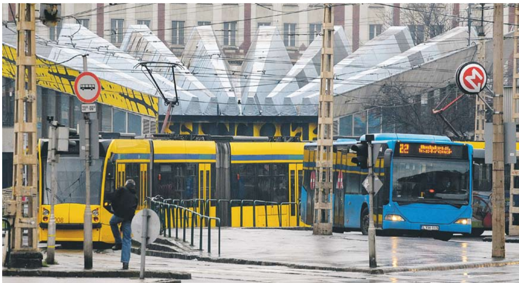
Erős csúszásban van a Széll Kálmán tér átépítése és a budai fonódó villamosvonal kiépítése is FOTÓ: MÓRICZ SIMON
