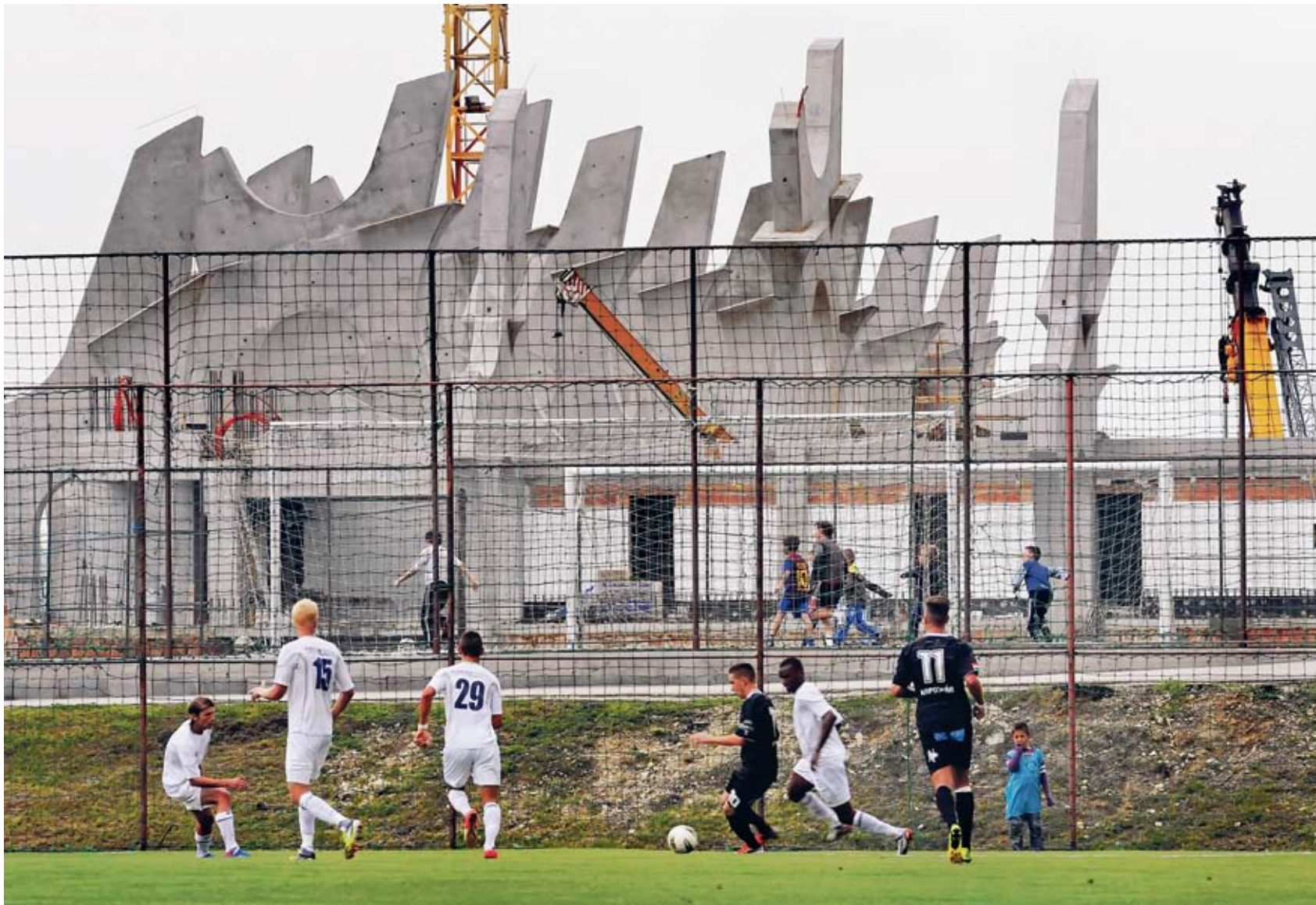
Beton, védelem FOTÓ: REVICZKY ZSOLT
